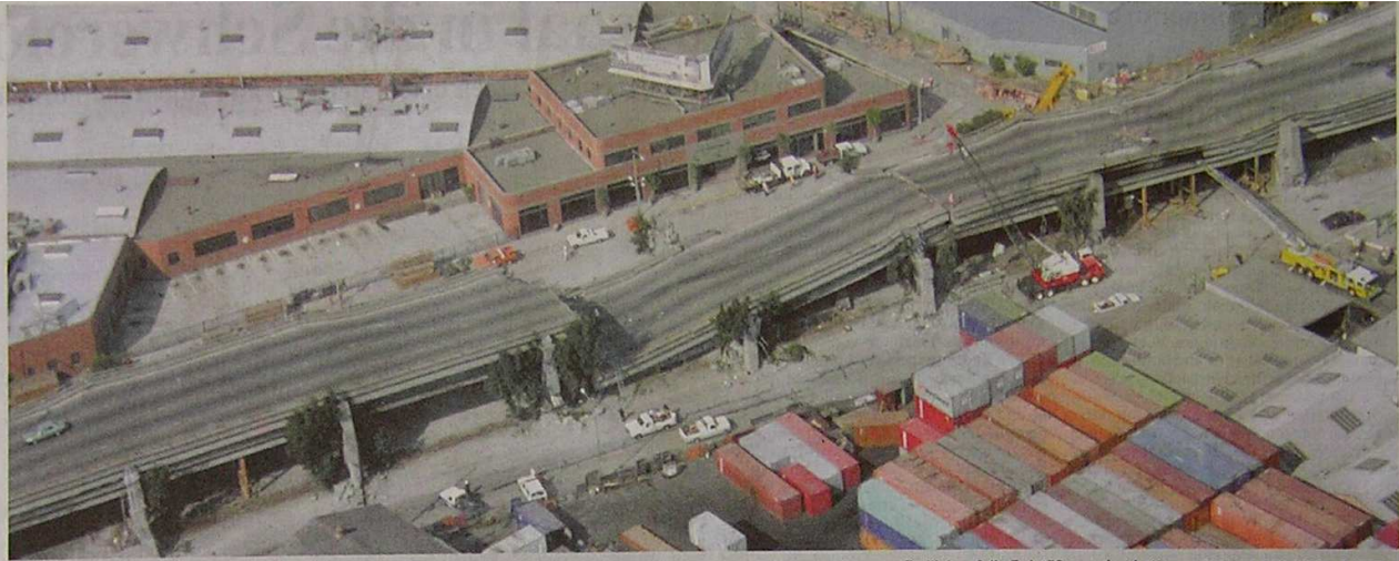
Diese Brücke in San Francisco stürzte 1989 bei einem Erdbeben ein. Ursache war der weiche Untergrund, der besonders empfindlich auf die Erdstöße reagiert hatte. FOTO: US GEOLOGICAL SURVEY
